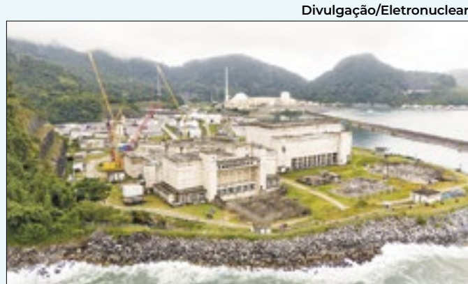
Obras de usina nuclear de Angra foram iniciadas em 1984
