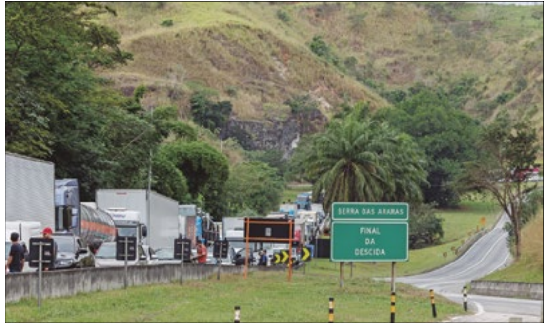
Novo traçado da Serra das Araras, na Rodovia Presidente Dutra, é um dos projetos em execução da CCR
