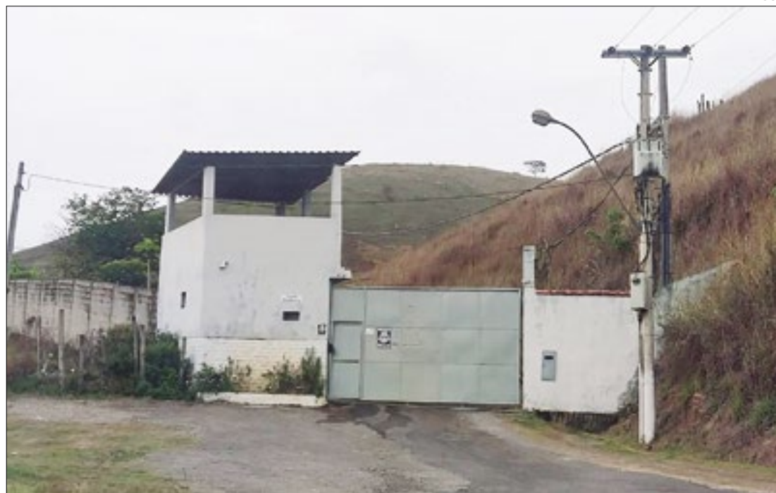
Distribuidora de combustível fica às margens da Rodovia do Contorno, em Volta Redonda
