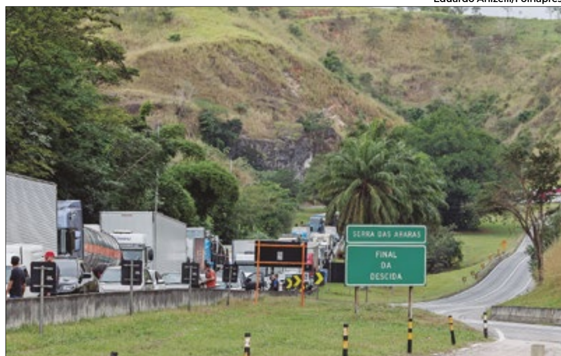
Novo traçado da Serra das Araras, na Presidente Dutra, é um dos projetos em execução
