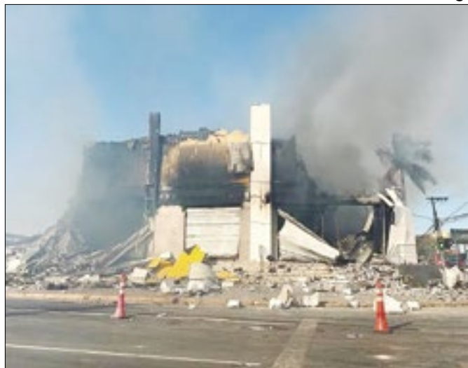
Shopping ficou completamente destruído pelo fogo
