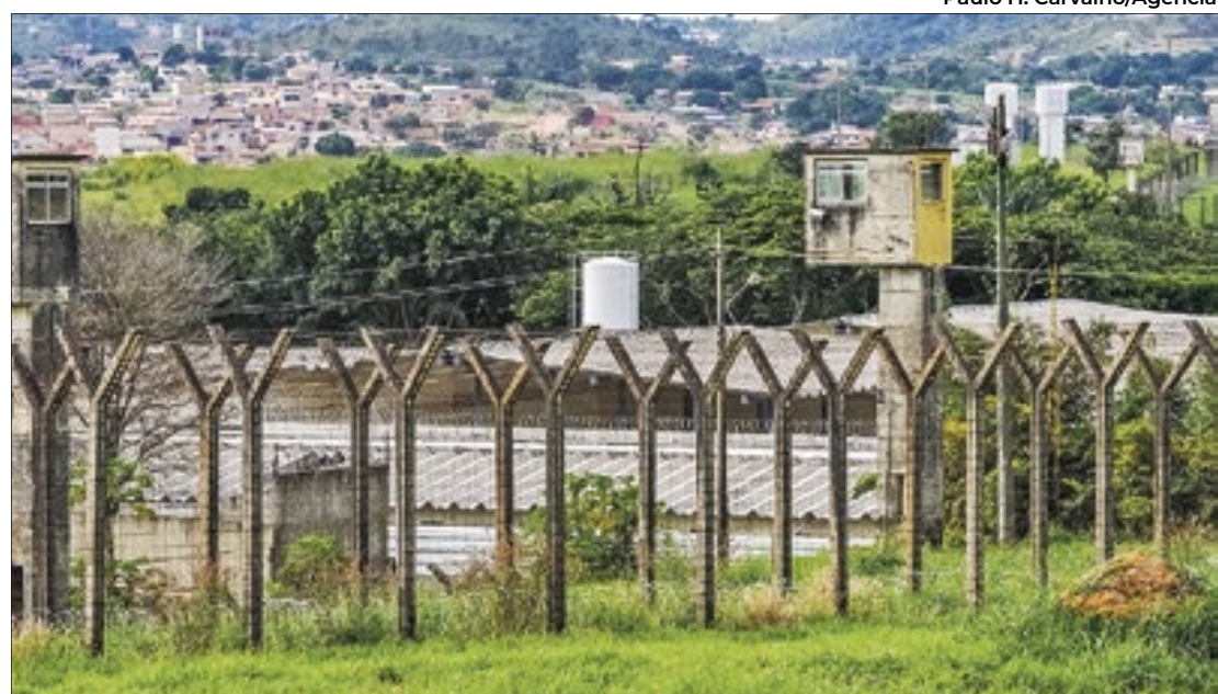
Ala será totalmente desativada em agosto
