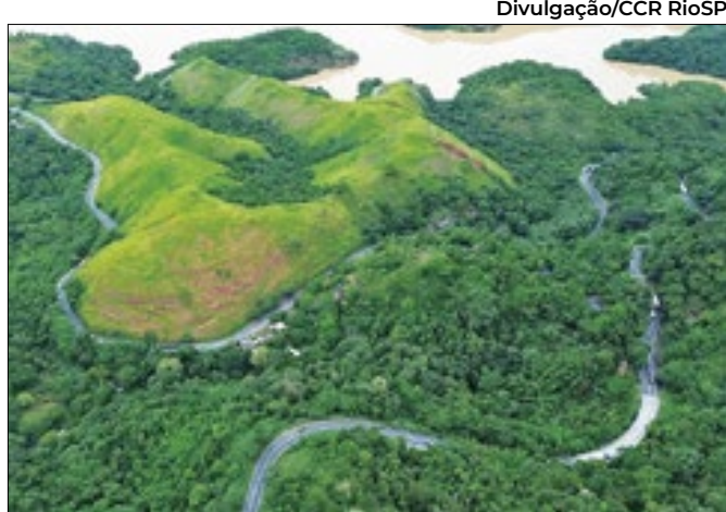
Pista de subida será bloqueada para detonações
