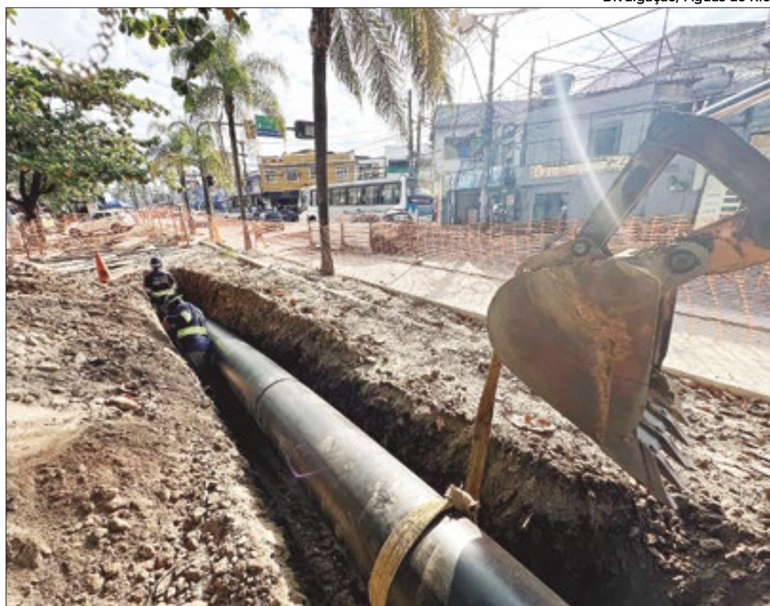
Nova rede vai encaminhar o esgoto para a Estação de Tratamento São Gonçalo
