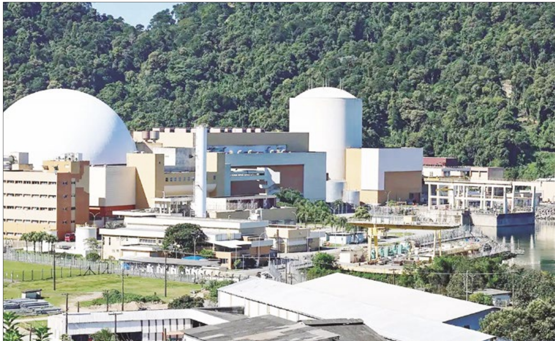
Os galpões das usinas nucleares de Angra dos Reis, no Estado do Rio, têm capacidade para receber material radioativo somente até o ano de 2030
