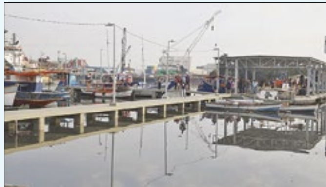
Pier do Caju foi entregue à comunidade reformado
