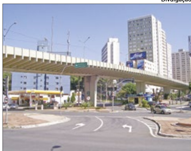
Novo viaduto Roza Cabinda é inaugurado
