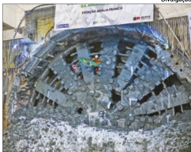
Tuneladora chega à estação Anália Franco e avança
