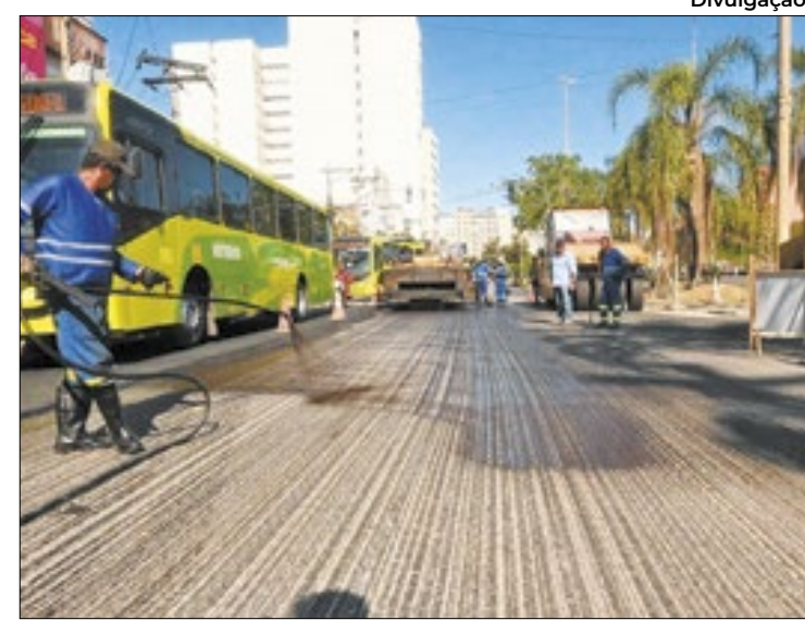
Obras acontecem em uma das principais avenidas da cidade
