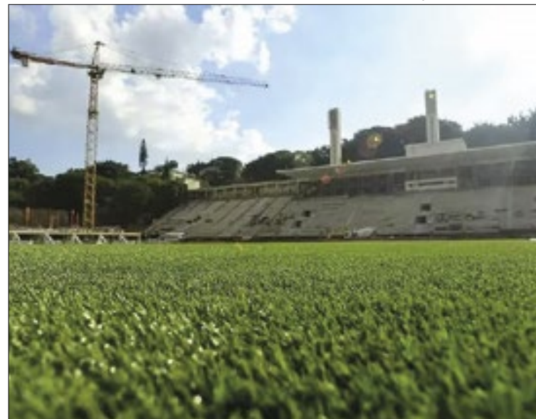
Obras no estádio estão em estágio perto do fim
