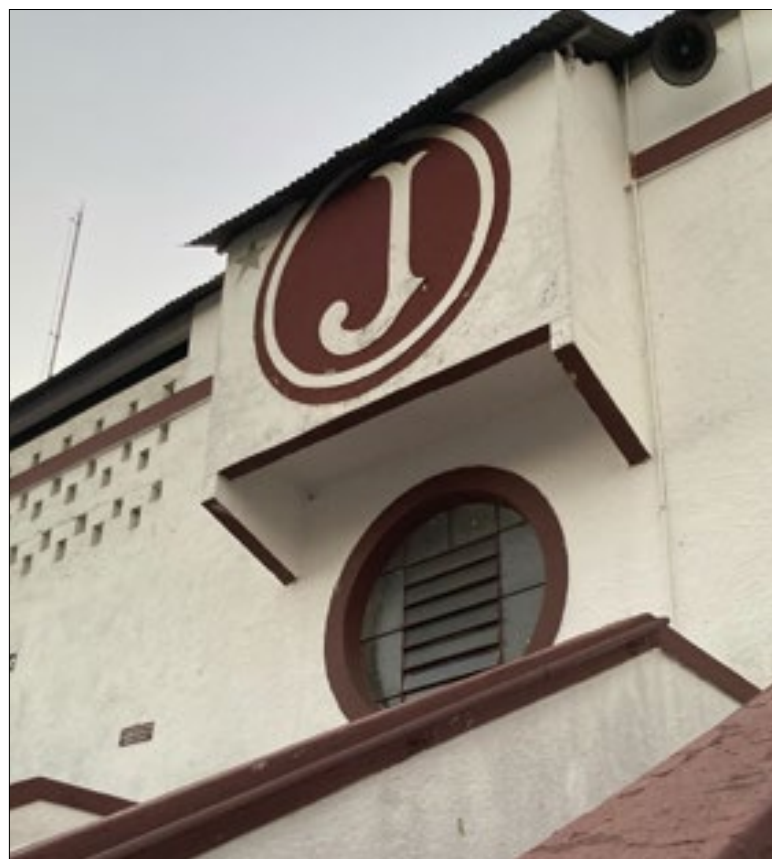
Nas arquibancadas da Rua Javari, o concreto forja uma nova geração de torcedores
