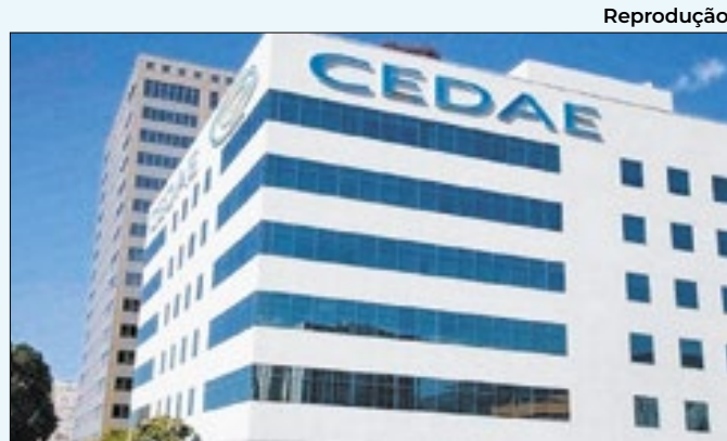
Intervenção faz parte da construção da ETA São Pedro
