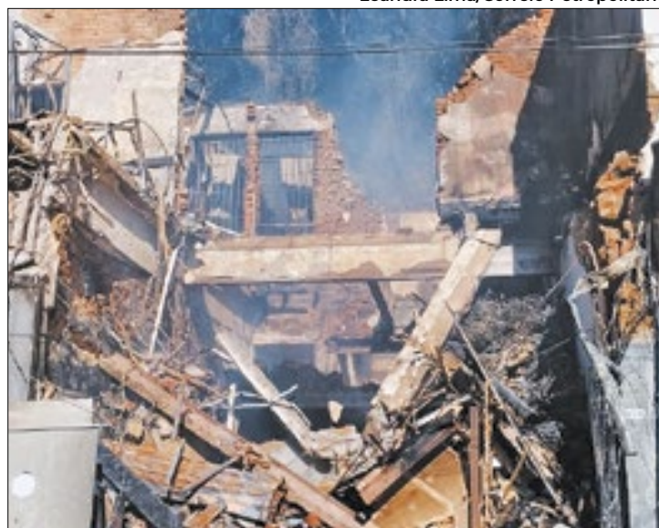
Estrutura dos estabelecimentos desabou com o fogo
