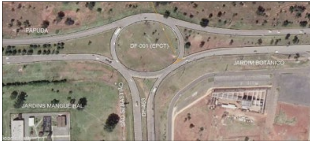
Local onde será feito o novo viaduto na região do Jardim Botânico. Os primeiros recursos para a obra já estão liberados
