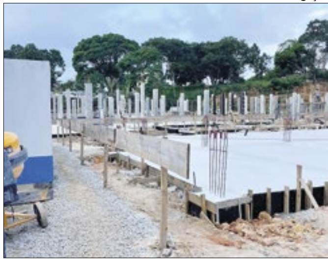
Obras da nova escola do bairro Engenho Grande
