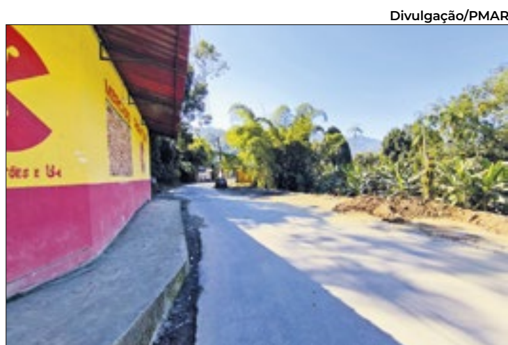
Via está sendo alargada e ganhará calçadas e ciclovia
