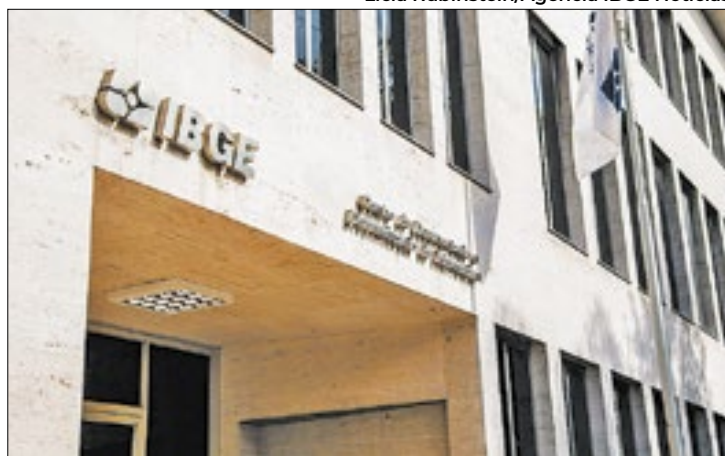
Prédio do IBGE situado no bairro Maracanã, Rio de Janeiro
