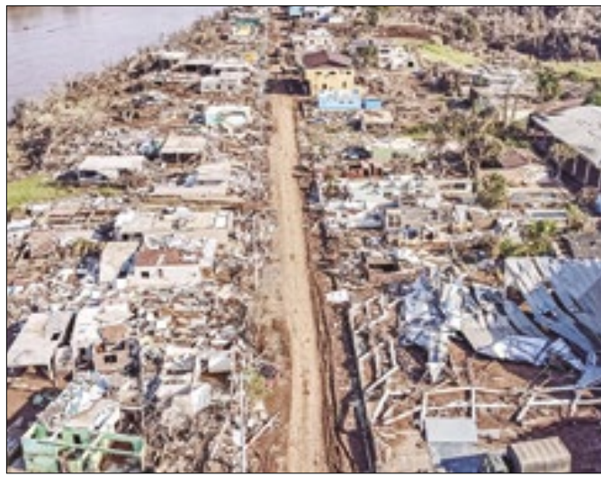
Desolação total na cidade de Arroio do Meio
