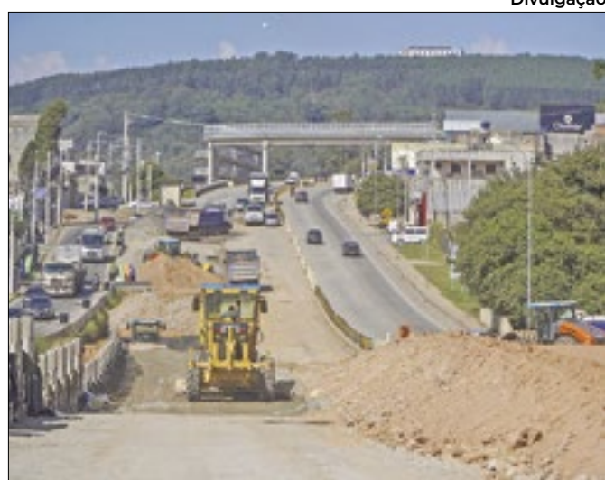
Governador Tarcísio de Freitas visitou as obras
