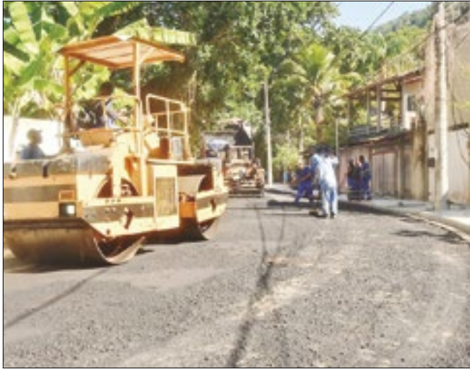
Bairro recebe pavimentação e construção de calçadas
