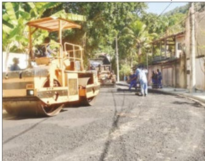
Bairro recebe pavimentação e construção de calçadas
