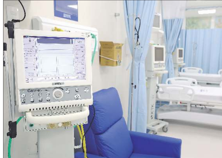
Novo Centro de Tratamento Intensivo Adulto com 16 leitos
