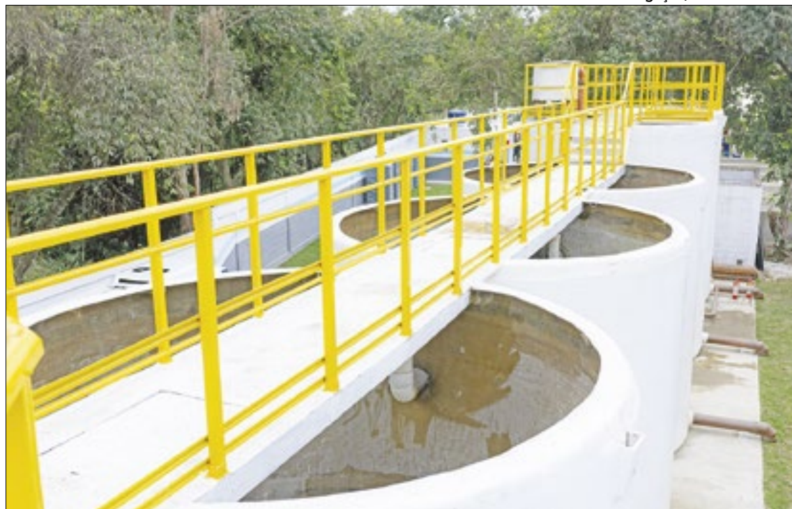
Estação de Tratamento de Esgoto (ETE) de Inoã terá 13 quilômetros
