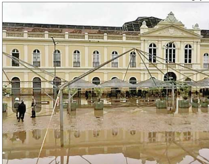
Prédio histórico de 1969 ficou alagado
