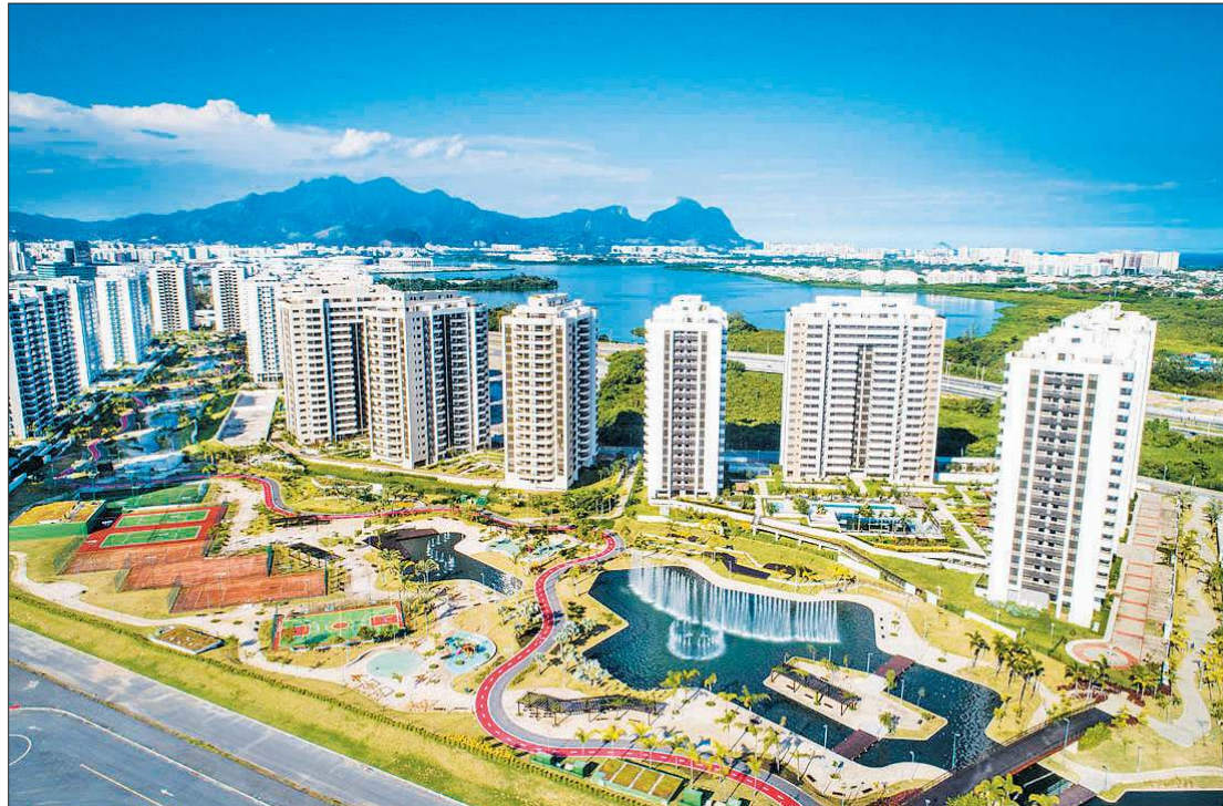
Ilha Pura, que foi a Vila Olímpica nos Jogos Rio 2016, foi construída pela Carvalho Hosken
