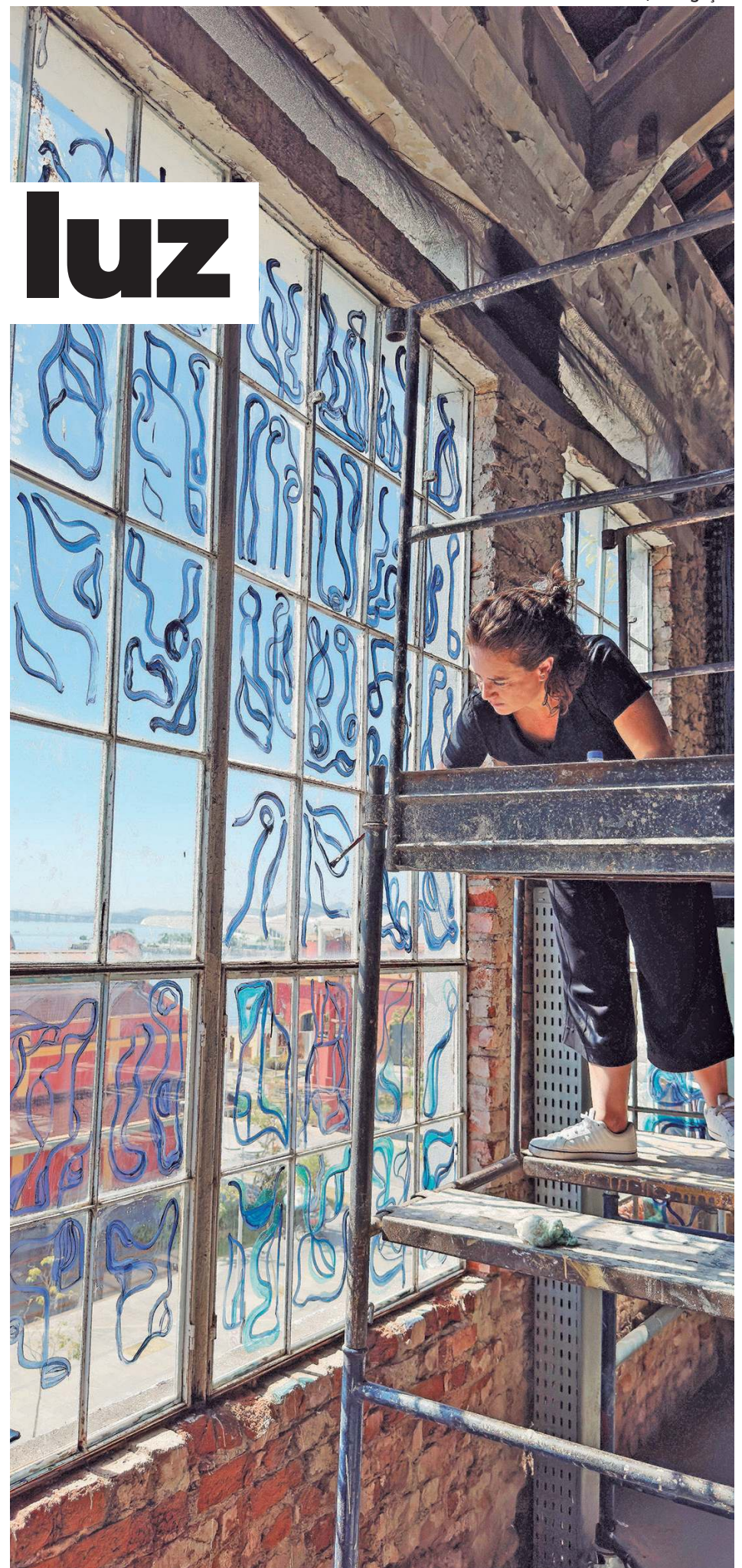
Artista visual e designer, Ana Coutinho trabalha na finalização dos painéis da instalação que será aberta ao público nesta quinta-feira
