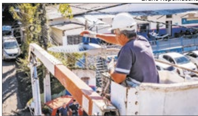
Equipes da prefeitura instalando o 'Smart Lighting'
