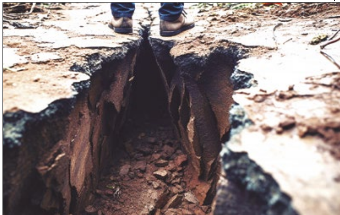
Mudanças climáticas podem causar deslizamentos e enchentes
