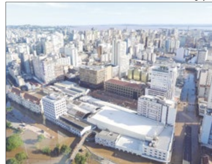
Sistema de contenção apresentou falhas
