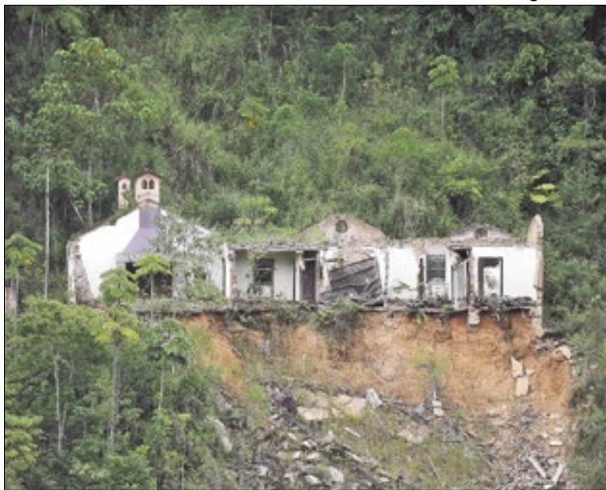
Teresópolis, casa destruída no bairro da Granja Florestal
