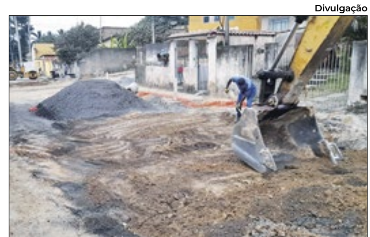
Obra era para inserir novas galerias de escoamento
