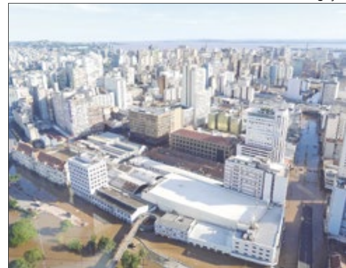
Sistema de contenção apresentou falhas
