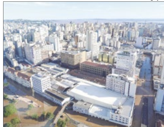
Sistema de contenção apresentou falhas
