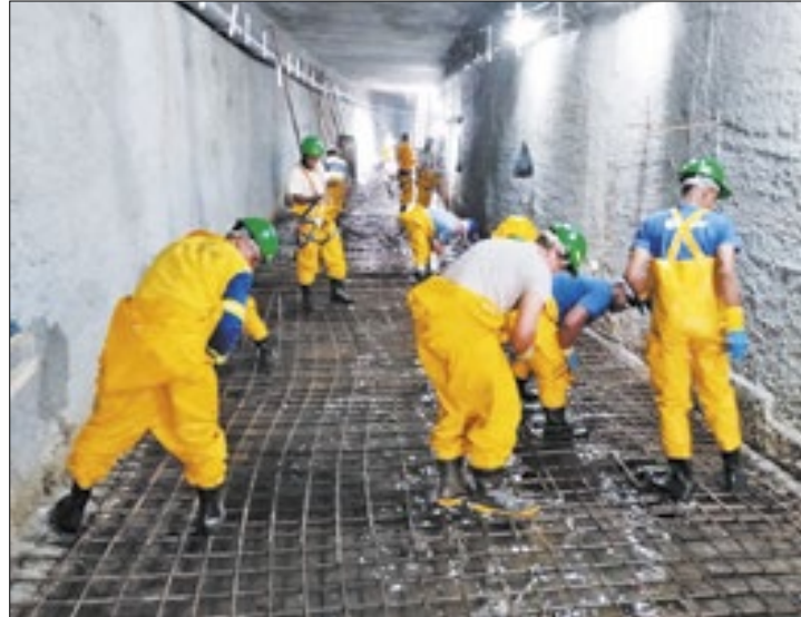
Concretagem no fundo do túnel extravasador em Petrópolis
