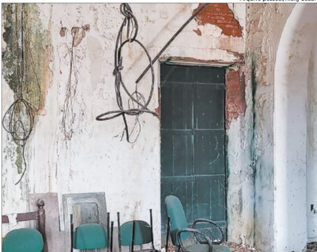
Raízes de embaúba se entrelaçam pelo telhado do museu, penetrando pelas paredes
