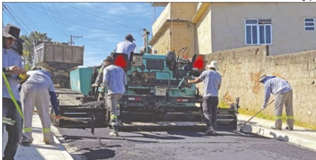
Obra no município faz parte do 'Programa Japeri Mais'
