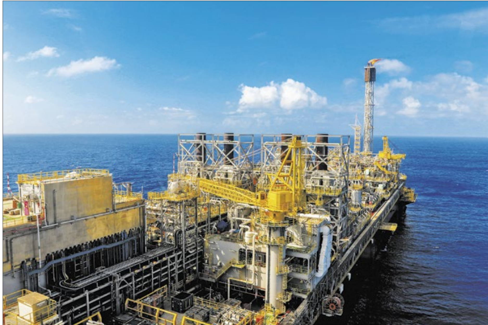
Vista aérea do navio-plataforma P-71, instalado no campo de Itapu, no pré-sal da Bacia de Santos
