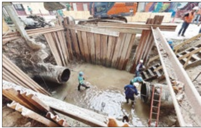
Tubulações vão evitar desperdício de água
