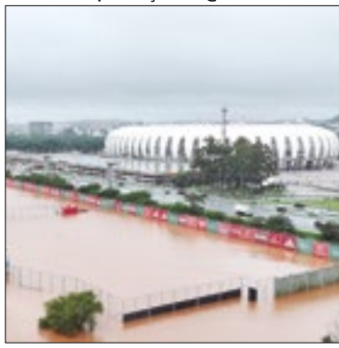
CT do Inter alaga após chuvas
