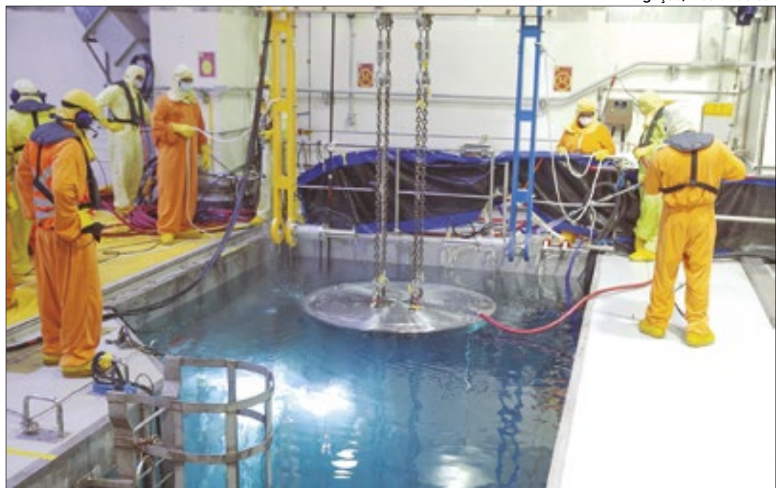
Retirada dos elementos combustíveis da piscina de resfriamento durante transferência
