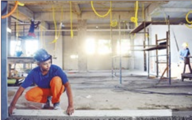
Obras na sede do Hemocentro em estágio avançado
