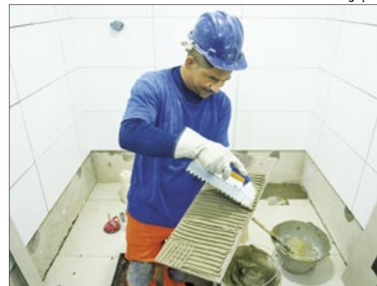
Hospital Ferreira Machado está com as obras aceleradas
