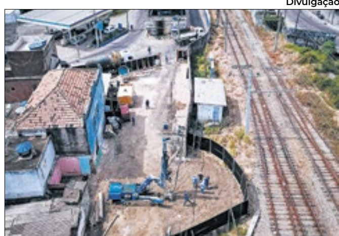
Após quatro anos paradas, obras foram retomadas
