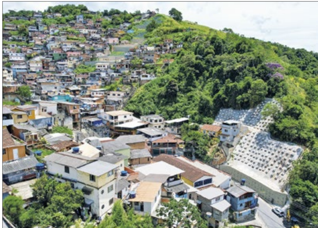
Rua 24 de Maio, comunidade afetada pela tragédia de 2022
