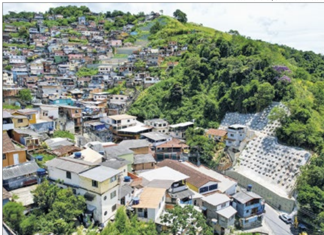
Rua 24 de Maio, comunidade afetada pela tragédia de 2022
