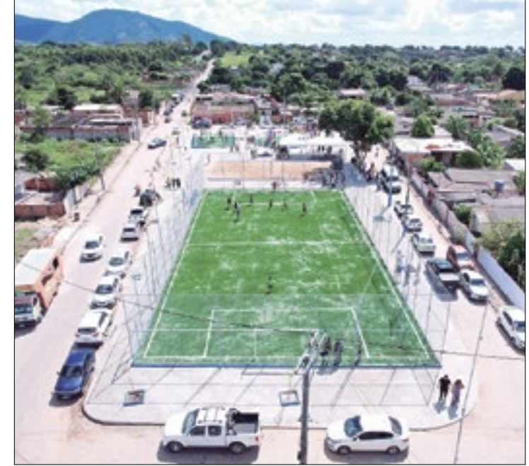
Localidades como Ururá, Tapera e Serrinha receberão obras
