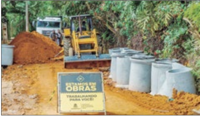
Obra na Rua México, em Albuquerque, em Teresópolis
