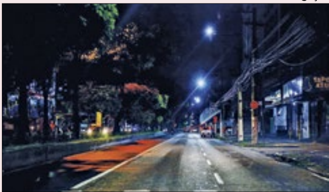
Cidade concluiu mais uma etapa da iluminação em LED
