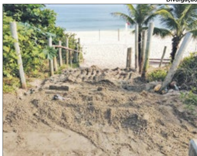
Agentes removem estrutura irregular em área ambiental
