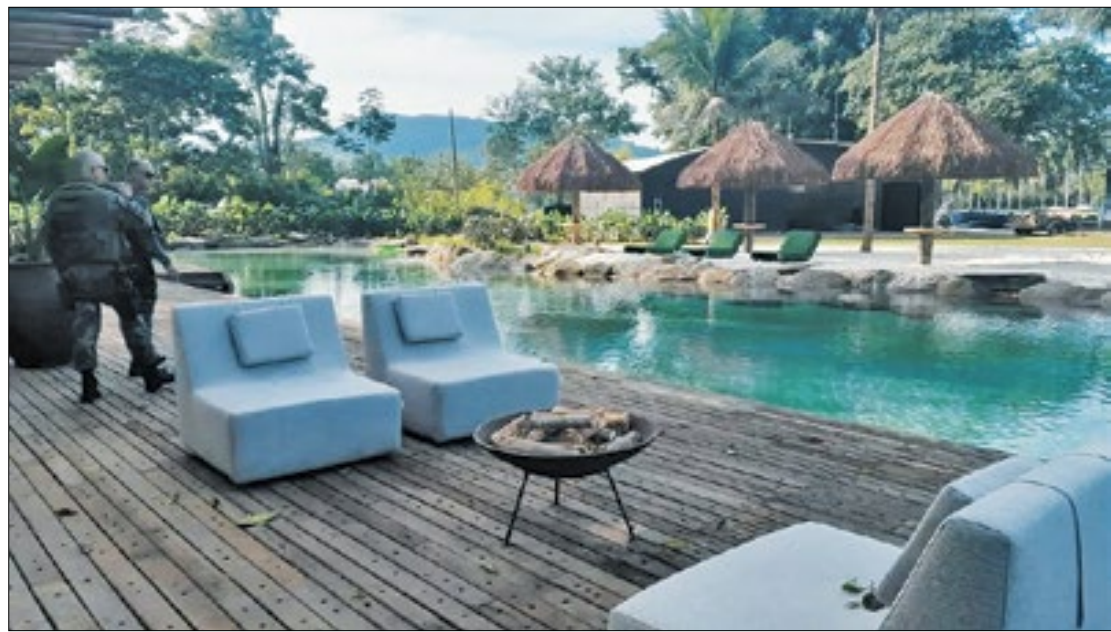
Obras em mansão chegaram a ser embargadas
