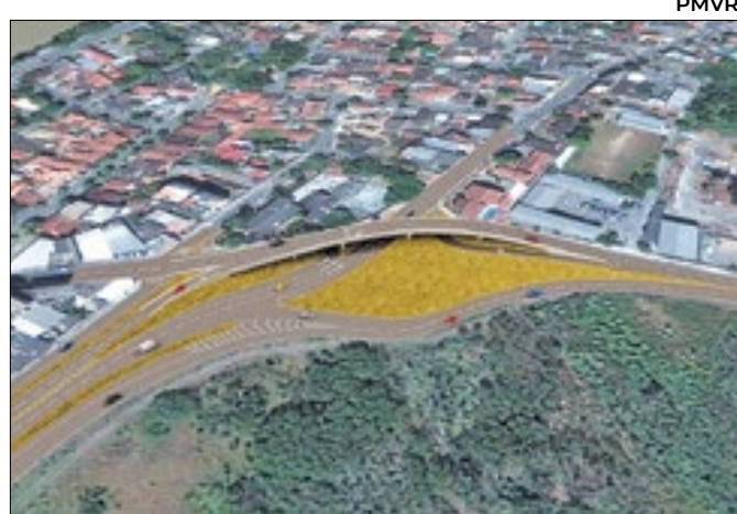
Construção beneficiará cruzamento entre avenidas
