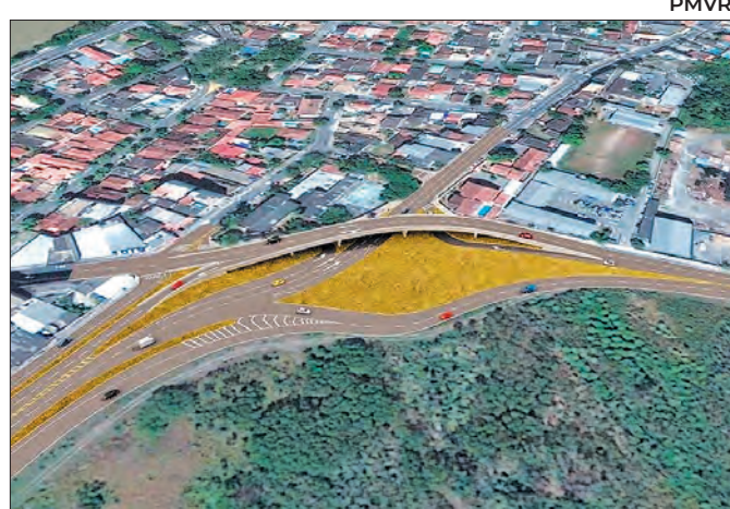
Construção beneficiará cruzamento entre avenidas
