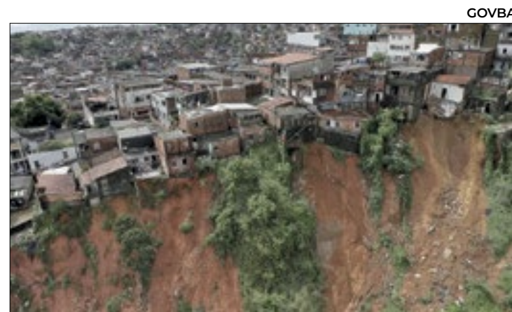
Chuvas em Salvador causa mais de 100 deslizamentos
