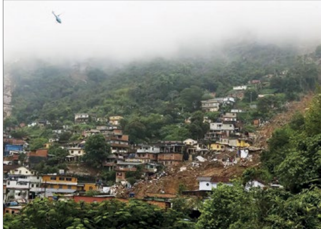
Tragédia das chuvas em Petrópolis, em 2022, matou mais de 240 pessoas
