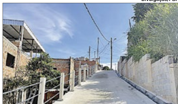
Obra faz parte do Programa Estrutural em Áreas de Risco
